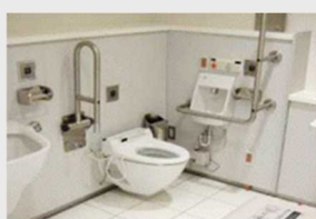
多機能トイレの整備
