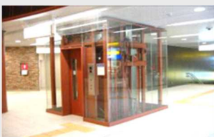
段差の解消（エレベーター）
